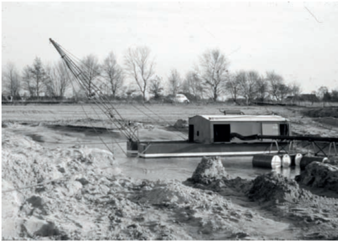
Entstehung des Westerholter Sees, Mohrmanns Saugbagger, 1972.
