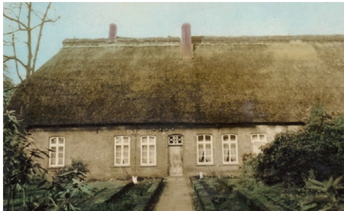
Haus Ammerländer Straße 66, Aufnahme von 1950 vor dem Umbau.
