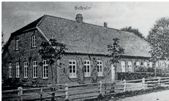
Die zweite Schule in Westerholt, um 1900, Ammerländer Straße 52. Erbaut 1871, verkauft 1911 an Heinrich Ripken, später an Cordes, heute ist Willi Wellmann Eigentümer.
